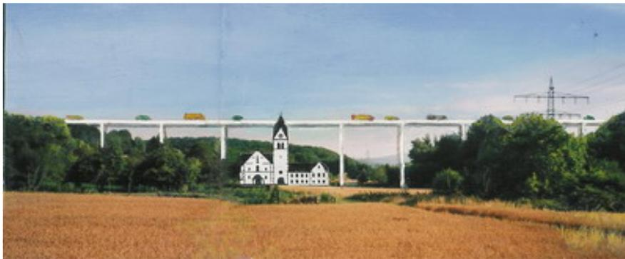
Abbildung 12: Fotomontage der Brücke über dem Liederbachtal (4-spurig, 32 m hoch, 438 m lang; zum Größenvergleich einmontiert: Kloster Hornau)
